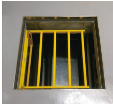
床点検口の蓋が開いていても、格子により転落を防止できます。
